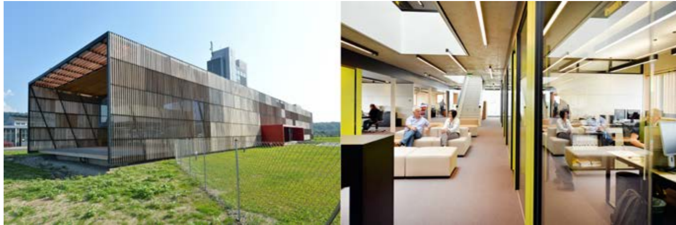
▲ Tradition und Regionalität sowie Zukunftsorientierung zugleich kennzeichnen die Marke Garant. Diese Werte wurden in eine Objektstrategie umgesetzt.
