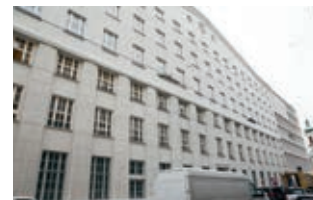
◀ Das denkmalgeschützte Telegrafnamt aus den zwanziger Jahren wird mit einem modernen, zeitlosen Neubau ergänzt.
