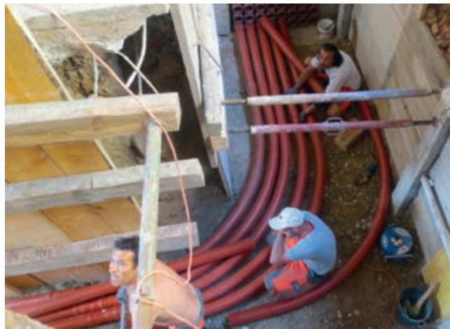
▲ Nach sorgfältiger Prüfung wurde der Kollektor-Gang, bestehend aus einer Vielzahl an Netzkabeln, noch vor eigentlichem Projektbeginn an die Grundstücksgrenze verlegt.
